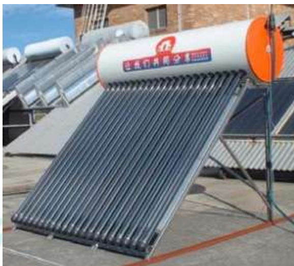
شكل (2): الجامع شمسي ذو الانابيب المفرغه [11]
