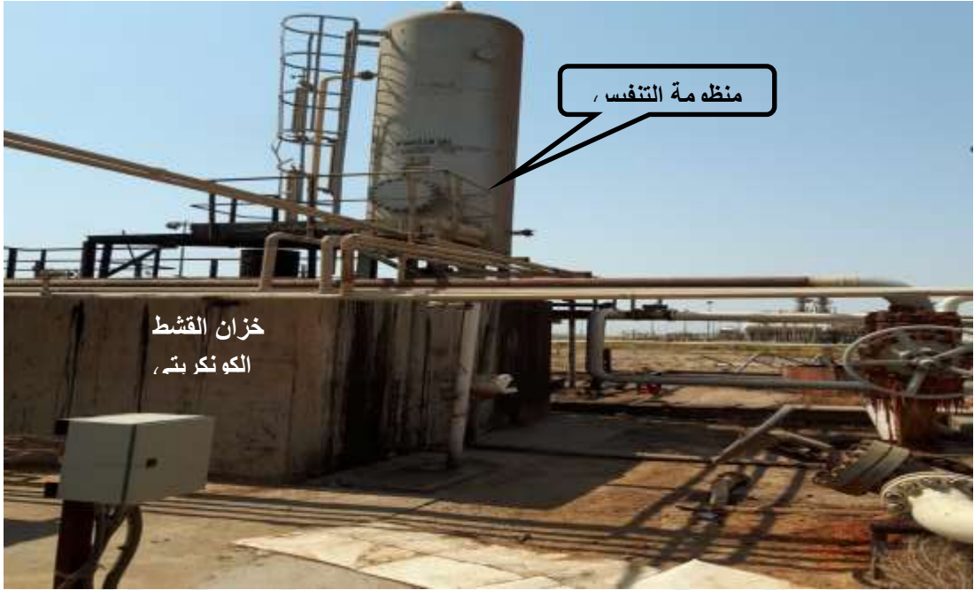
صورة رقم (٣): منظومة التنفيس في منظومة معالجة المياه النفطية المصدر : وزارة النفط ، قسم الاعلام ، شركة نفط الوسط .
